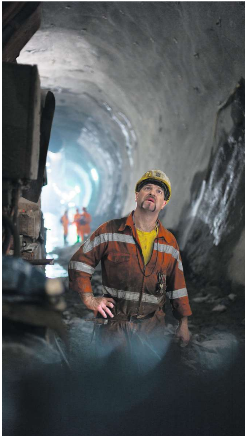
Ingenieure auf der Baustelle des Gotthardbasistunnels.
