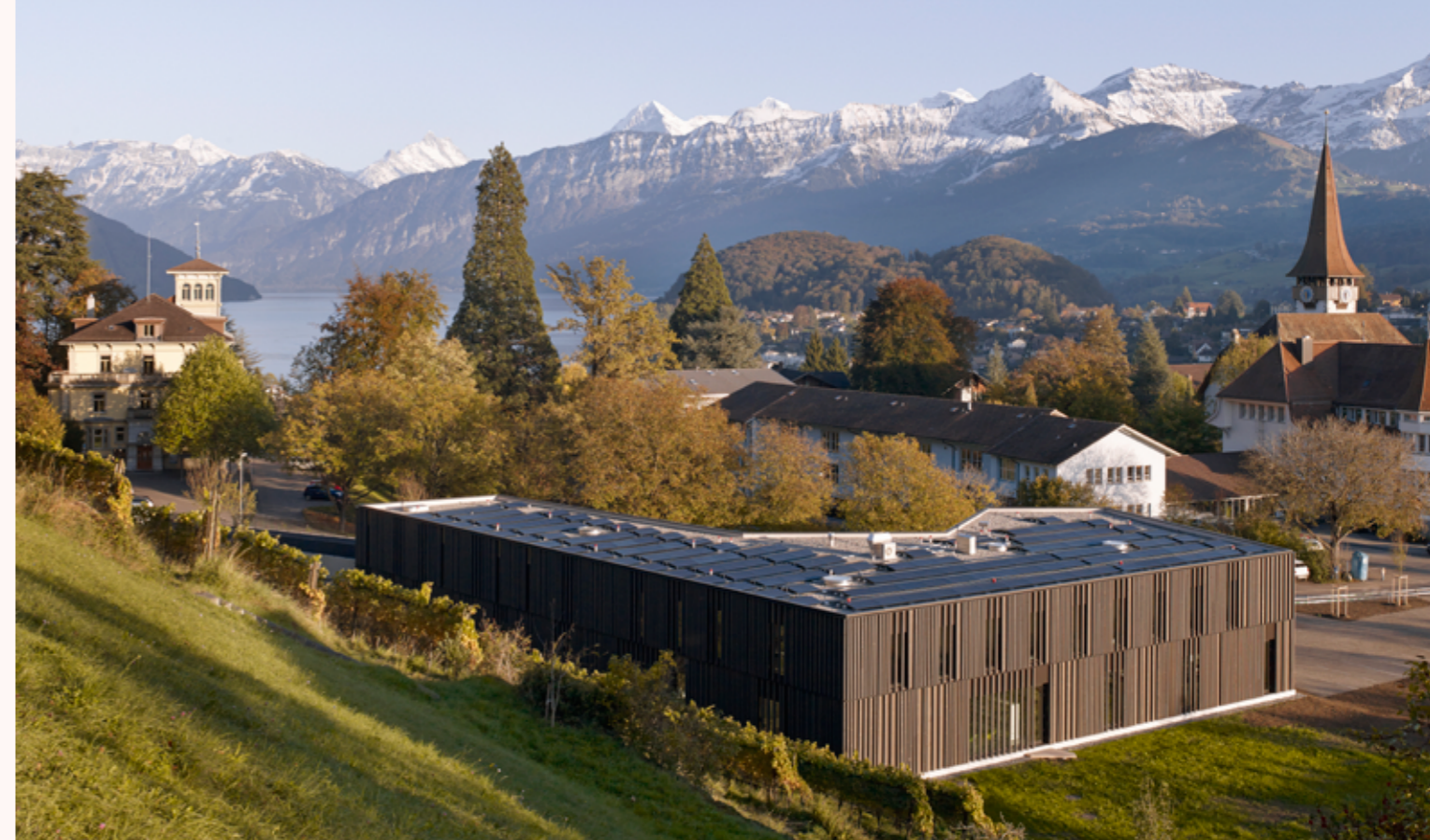
Die frisch eingeweihte Bibliothek/Ludothek in Spiez: So schön kann das Resultat öffentlicher Beschaffung nach Bauabschluss aussehen.
