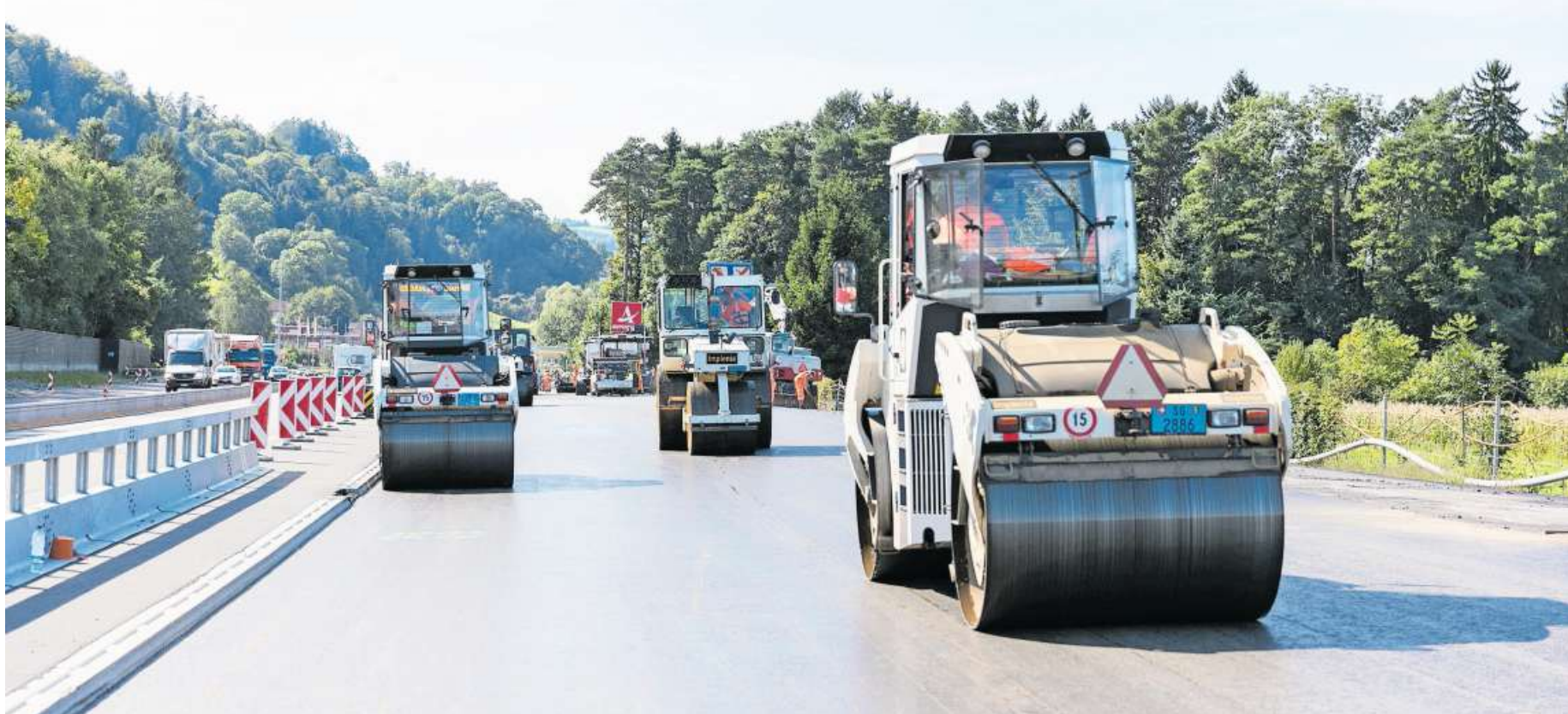
Die Astra-Filiale Winterthur vergibt jährlich Aufträge für über eine halbe Milliarde Franken: Bauarbeiten auf der Autobahn bei St. Margrethen (SG). (September 2017)
